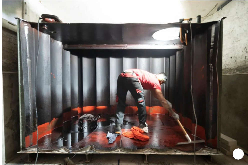
Dieser Heizöltank wurde vor zwei Jahren abgebaut, das Haus in Zürich an das Fernwärmenetz angeschlossen.
